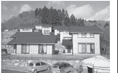
石巻市北上町白浜住宅全景。津波の影響がない標高40~60mに建設した
